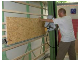
Zuschneiden der Platten
